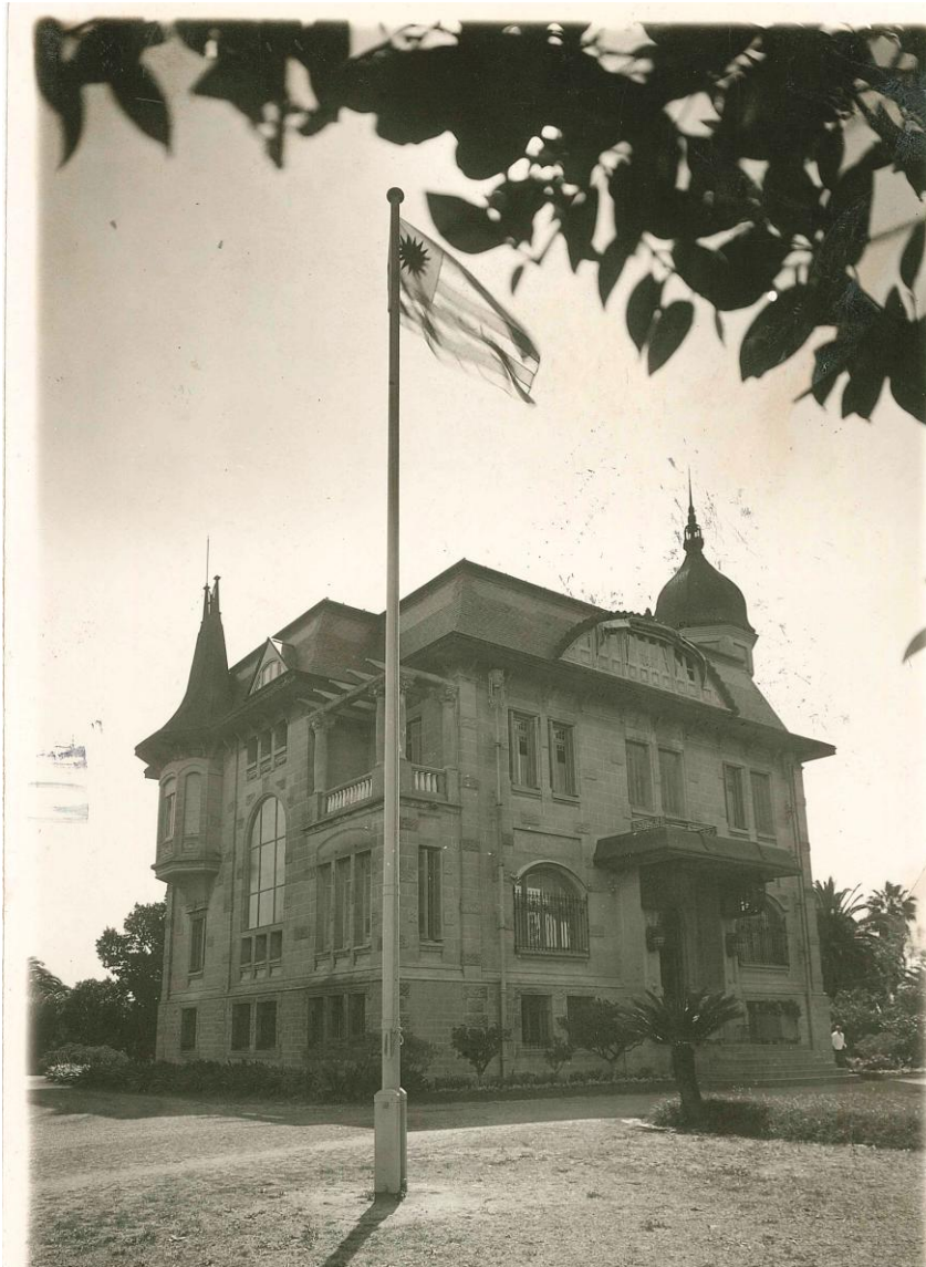
Fotografía exterior del Edificio del Servicio Hidrográfico de la Marina, desde 1941 hasta 1947
