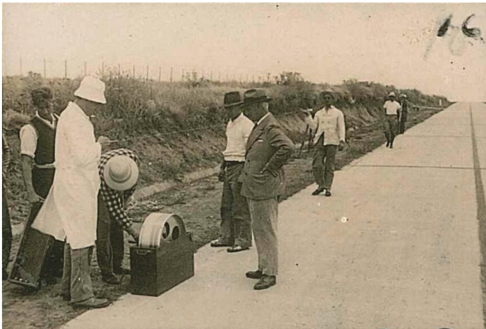
Fotografía de la Medición con Hilo Invar de la Base de Colonia 1935
